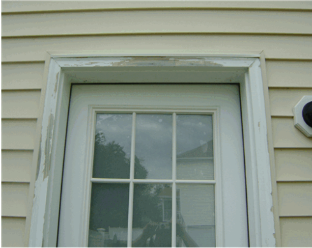
Exterior garage door
